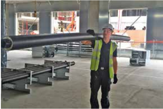
Aufgrund des geringen Gewichts von COOL-Fit 2.0 konnten die Installateure sogar meterlange Rohrleitungen leicht schultern
