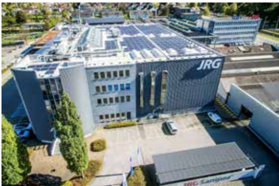
Ein exzellentes Beispiel für die Reduktion von CO 2 -Emissionen durch die Nutzung von erneuerbaren Energien ist die Produktionsstätte von GF Piping Systems in Sissach (Schweiz)
